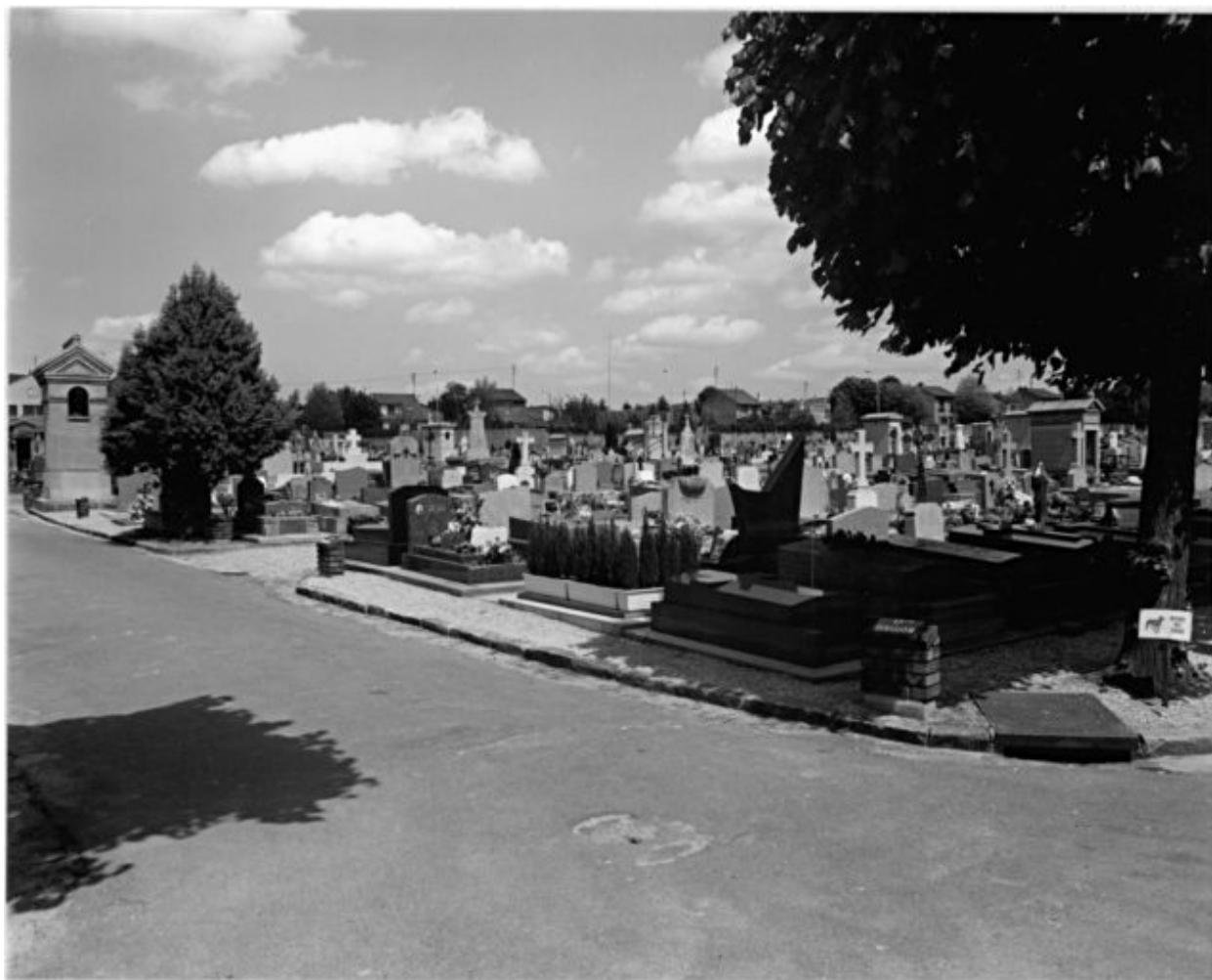
Vue générale de la partie nord.
