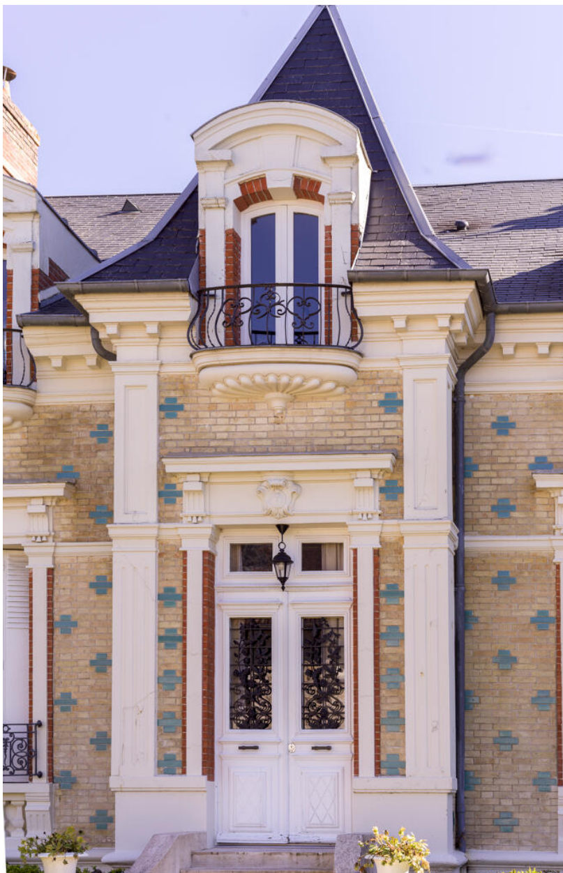
Vue de la travée centrale.
