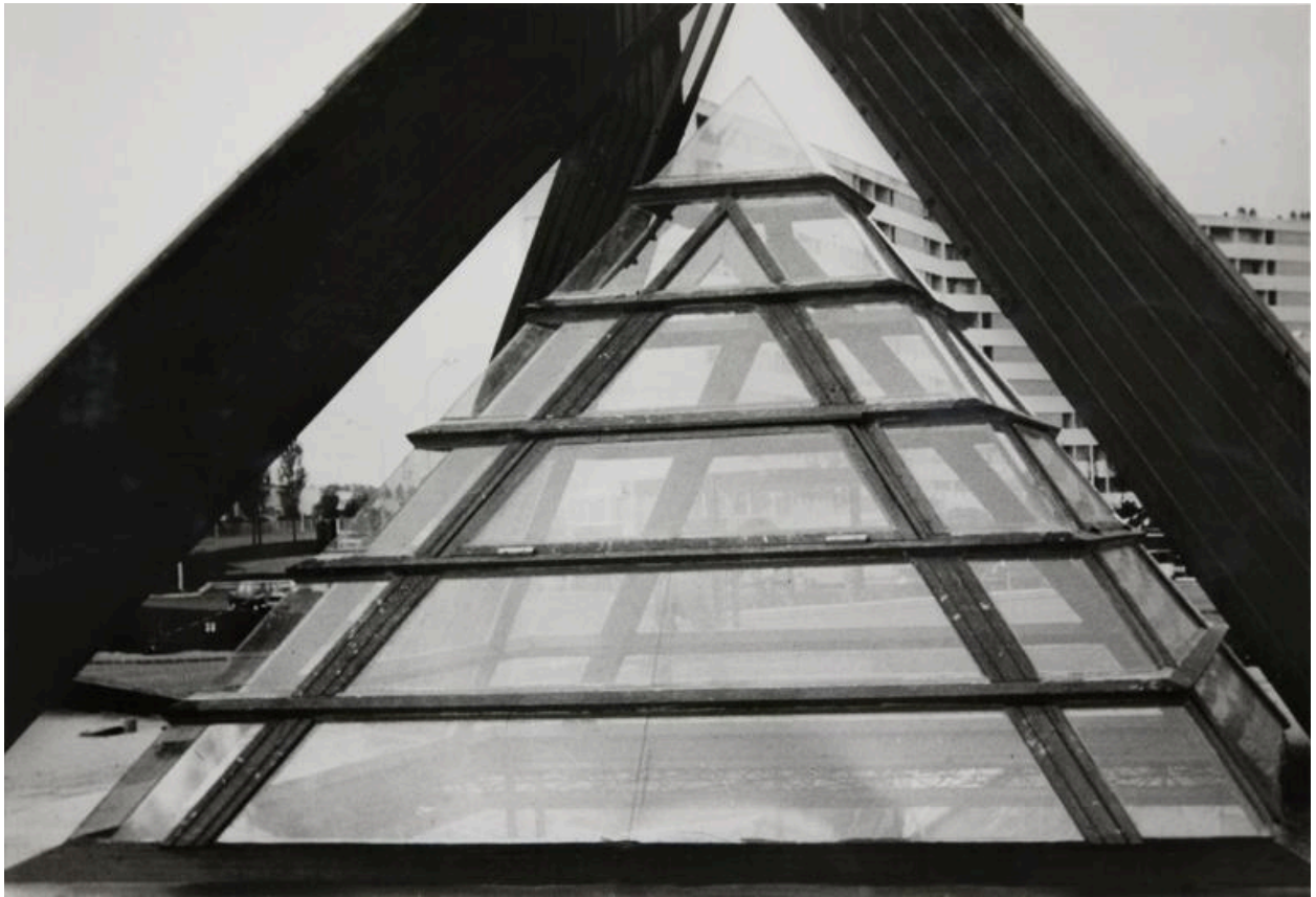
Vue rapprochée de la pyramide de verre centrale (état d'origine).
