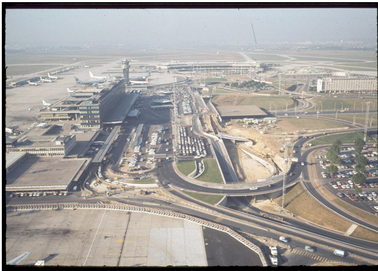
1972, construction du parking souterrain P4 vue depuis l'est.
