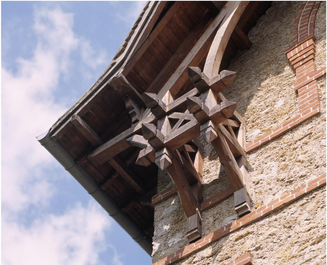
Détail d'un aisselier (façade sur jardin).
