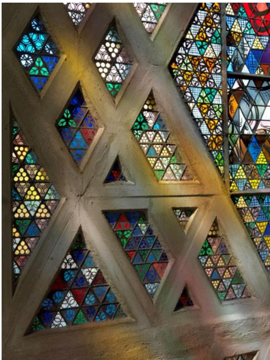
Détail des vitraux insérés dans la structure en béton.
