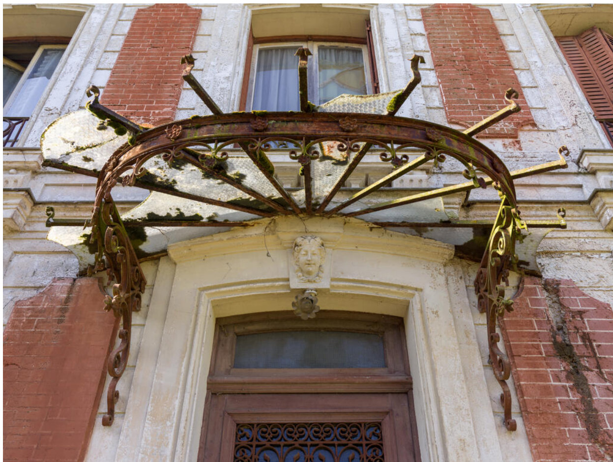
Vue de la marquise.
