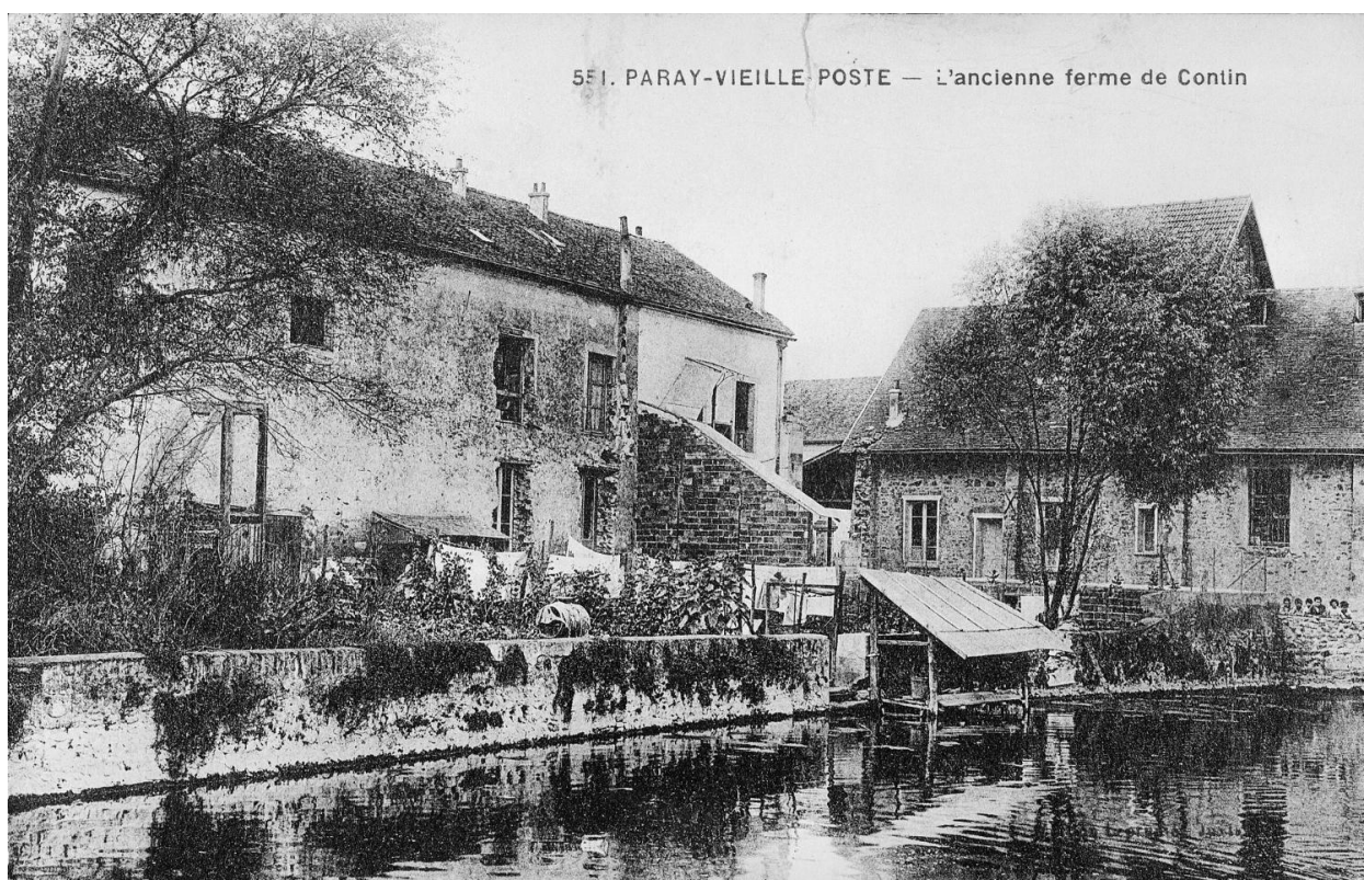
Vue des bâtiments à côté de la mare et du lavoir aujourd'hui asséchés.
