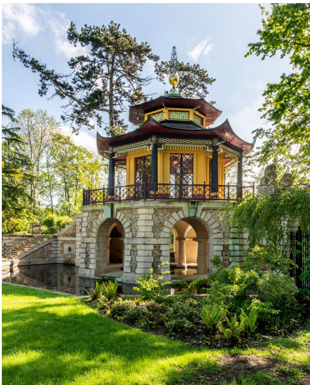
Vue de trois quarts, du côté déversoir.
