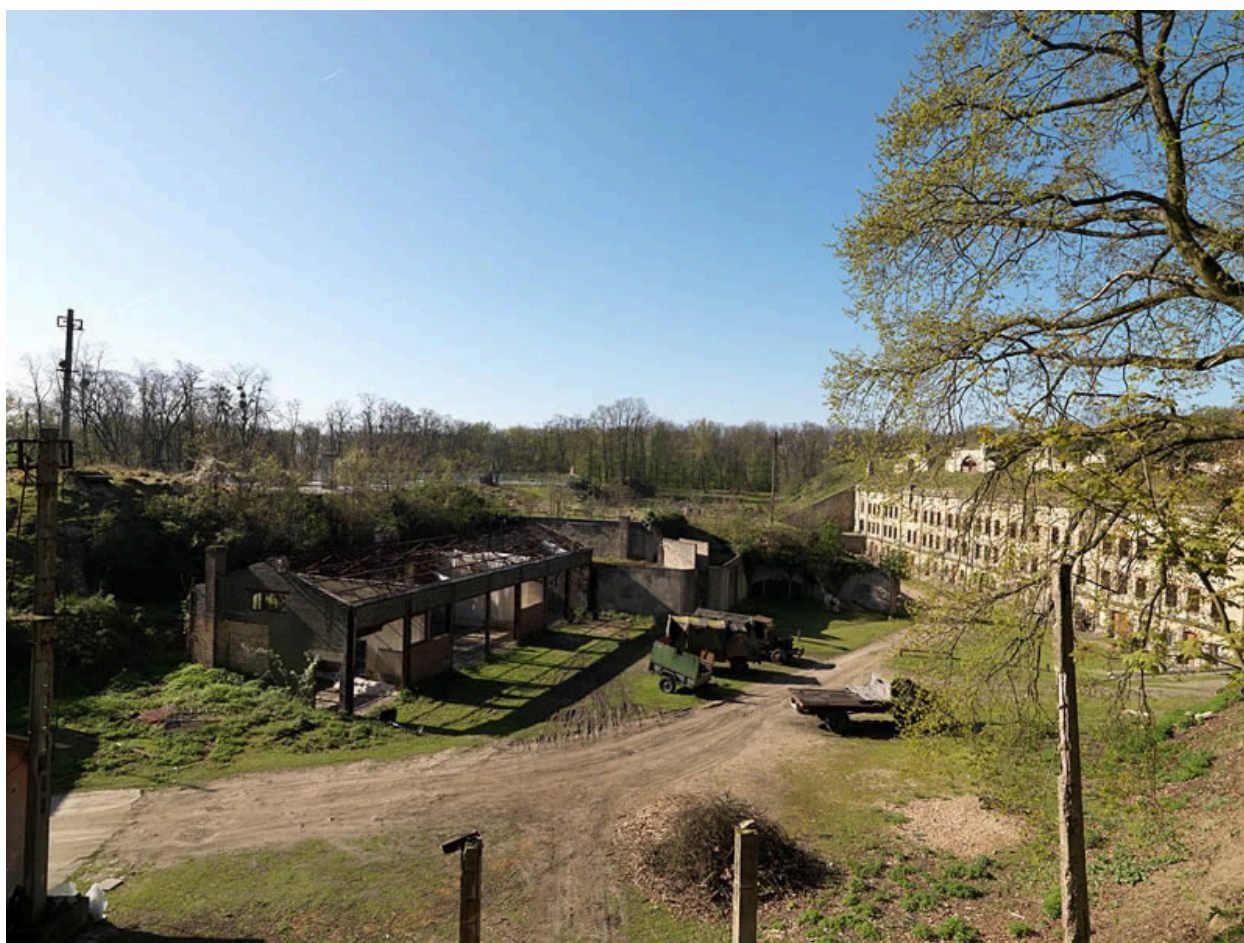
Vue générale de la caserne de la troupe en direction de l'ouest.
