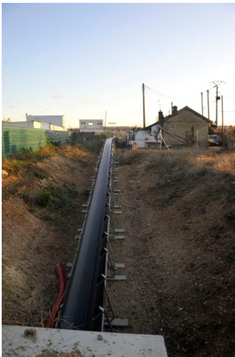
Triel-sur-Seine, carrière (sablère et gravière) Lafarge Granulats, 2 chemin des Graviers. Bande transporteuse.
