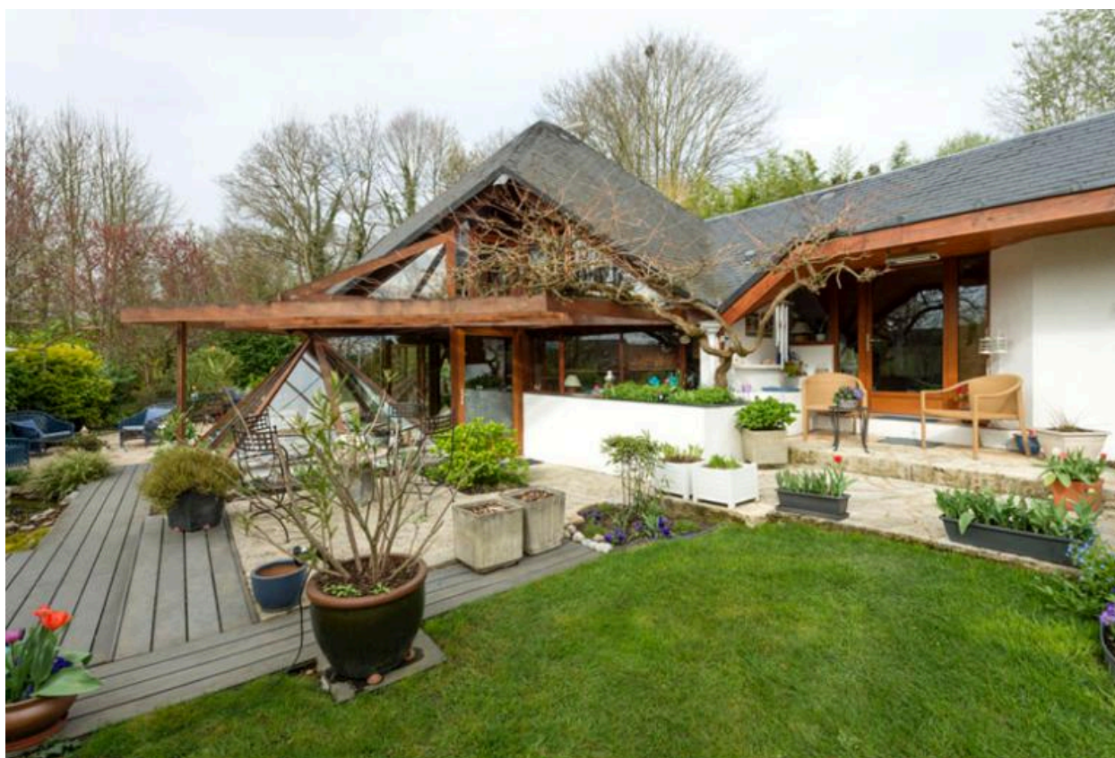
Vue générale de la façade principale : orientation vers l'extrémité Ouest.
