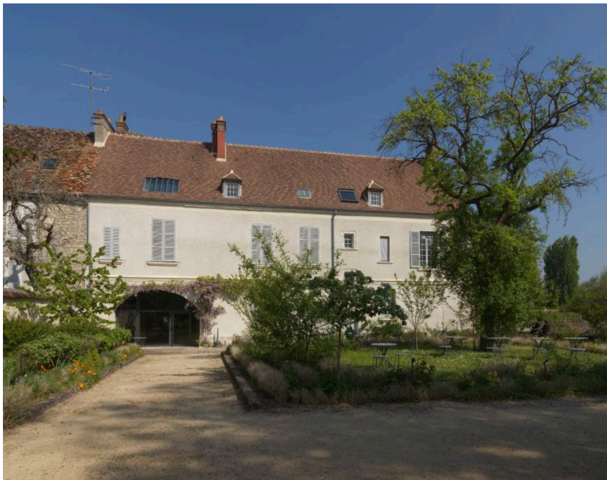
Vue de la façade postérieur du bâtiment principal (3)
