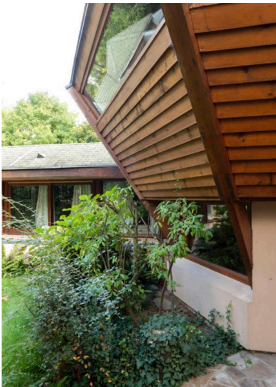
Vue rapprochée de l'élément central de la façade postérieure.
