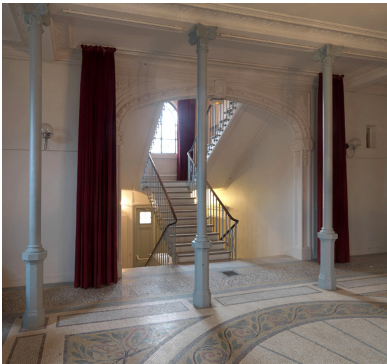
Le hall central et les colonnettes de fonte soutenant la galerie.
