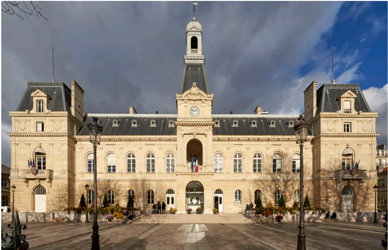
Vue générale de la mairie et du parvis.
