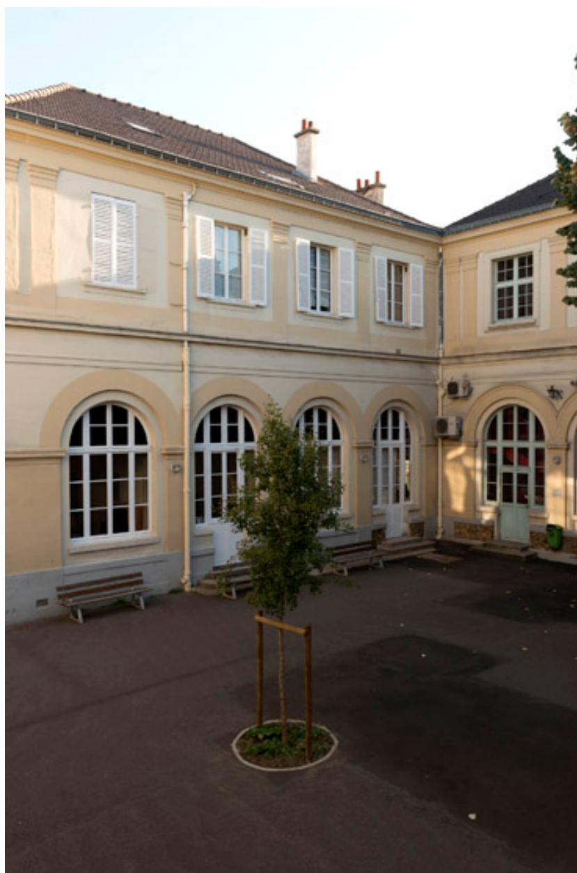
La jonction entre deux bâtiments.
