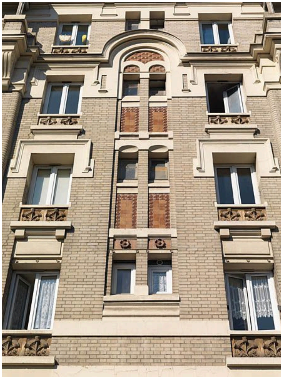
Villeneuve-Saint-Georges, immeuble, 33 rue Henri Janin . Détail.
