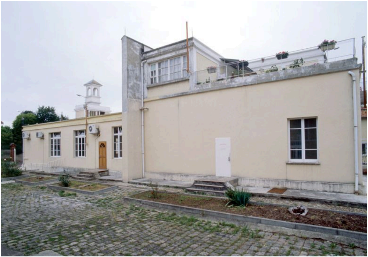
Vue latérale du bâtiment administratif (façade ouest).
