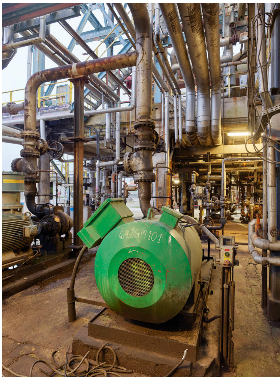
Unités Ouest - Zone de distillation (Unité 612). Pompe d'entrée du pétrole (appelée pompe de charge), juste après le bac.
