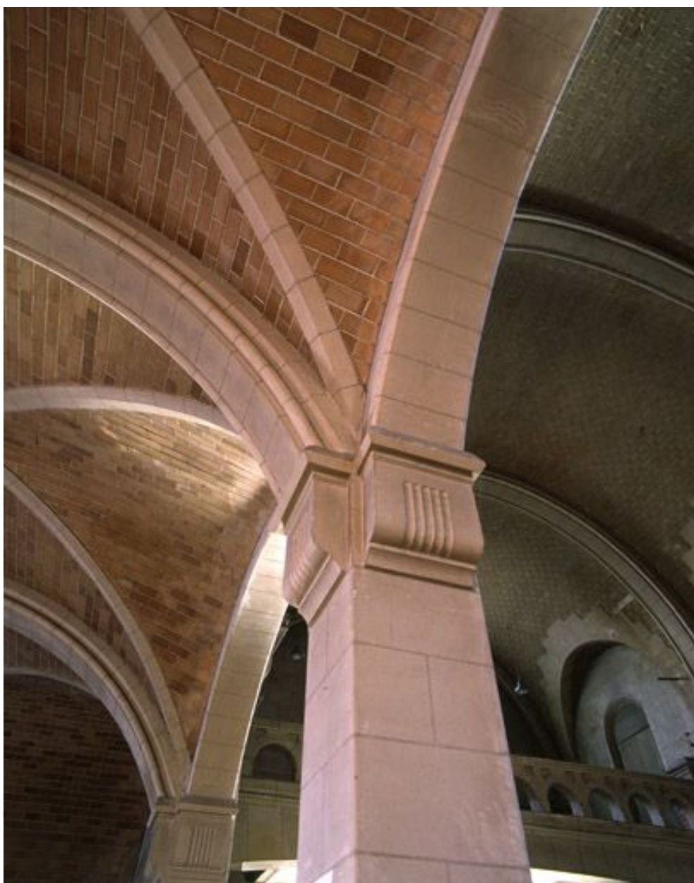
Détail d'un chapiteau et du départ de la voûte.
