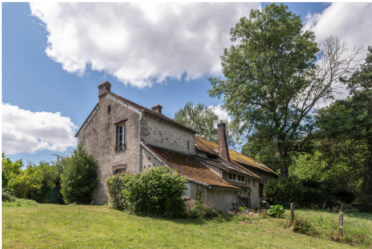
Corps de logis, façade postérieure, nord, et façade est.
