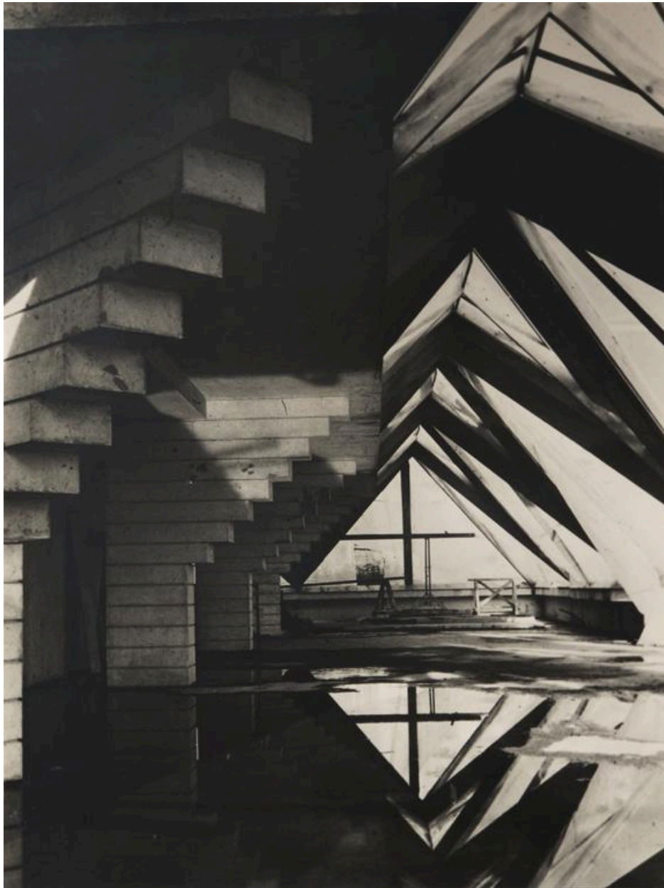
Intérieur de l'édifice en construction.
