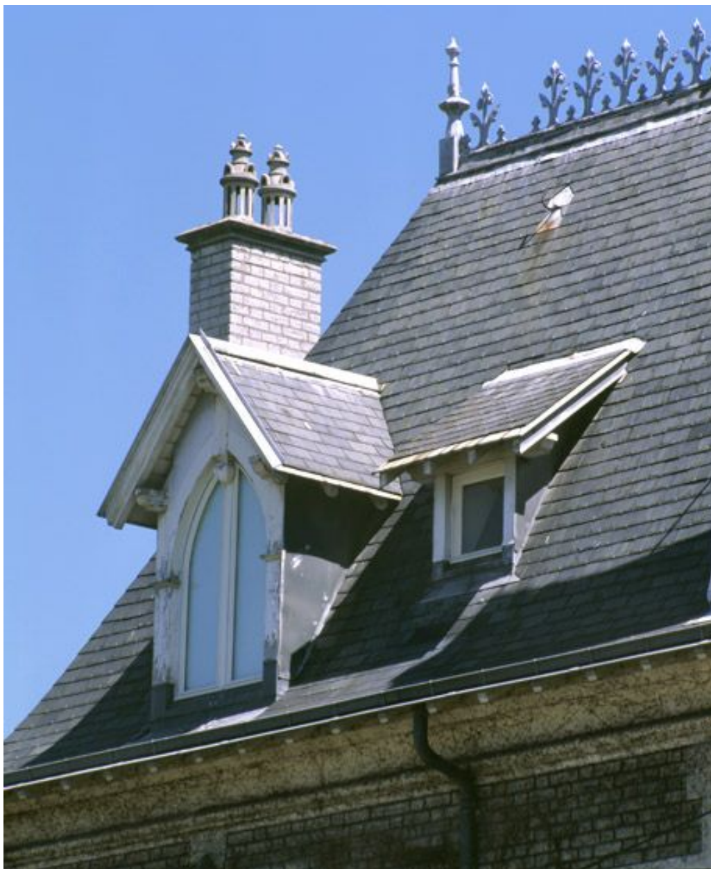
Maison, 2 avenue du Général de Gaulle. Détail d'une lucarne, de deux mitrons surmontant une souche de cheminée et de la crête au motif floral.
