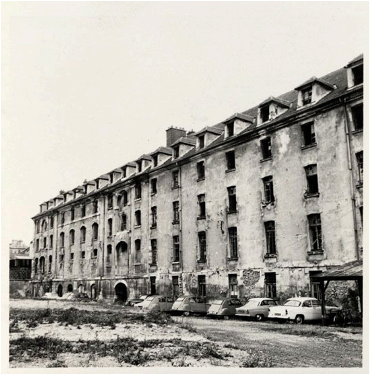
Photographie des anciens bâtiments de l'abbaye Notre-Dame du Marché, reconvertie en quartier de cavalerie, avant démolition : vue extérieure. Photographie, vers 1965. (Médiathèque Luxembourg, Meaux. Fonds Endrès )
