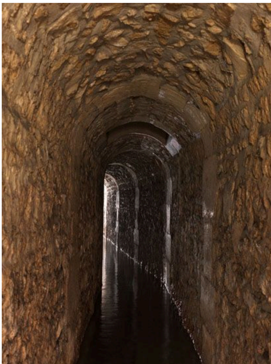
Rungis. Vue de l'intérieur de la galerie entre le regard I et II.
