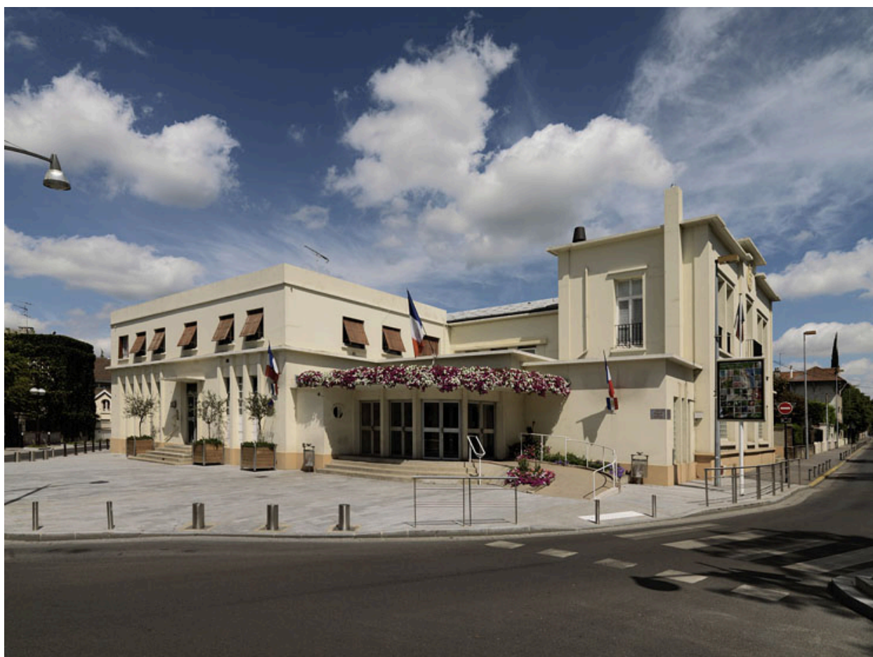
Vue d'ensemble depuis l'avenue de Ceinture.
