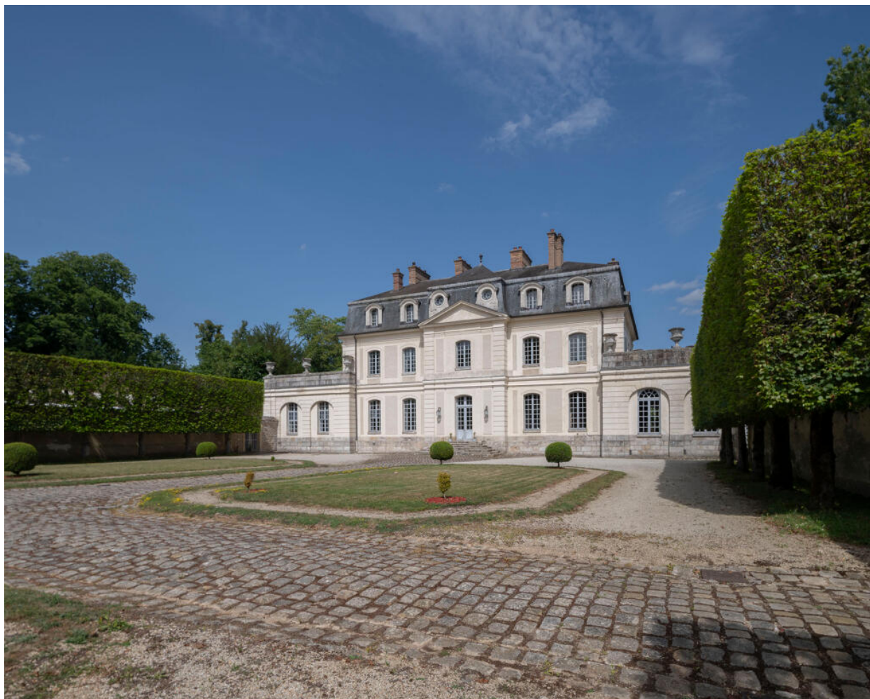
Façade sur cour.
