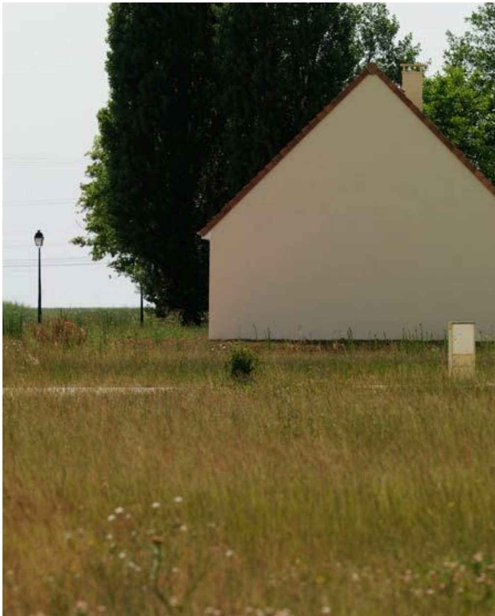
Roinville. Lotissement au lieu-dit Le Goulet.
