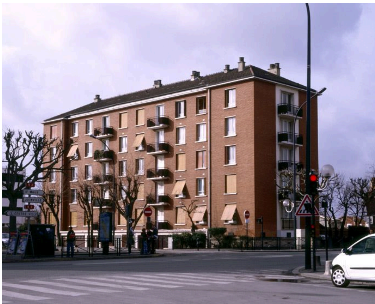
Cité, 112-114 avenue Roger Salengro. Vue de la façade sur la rue Benjamin-Moloïse. Heulot, Julien (architecte communal)
