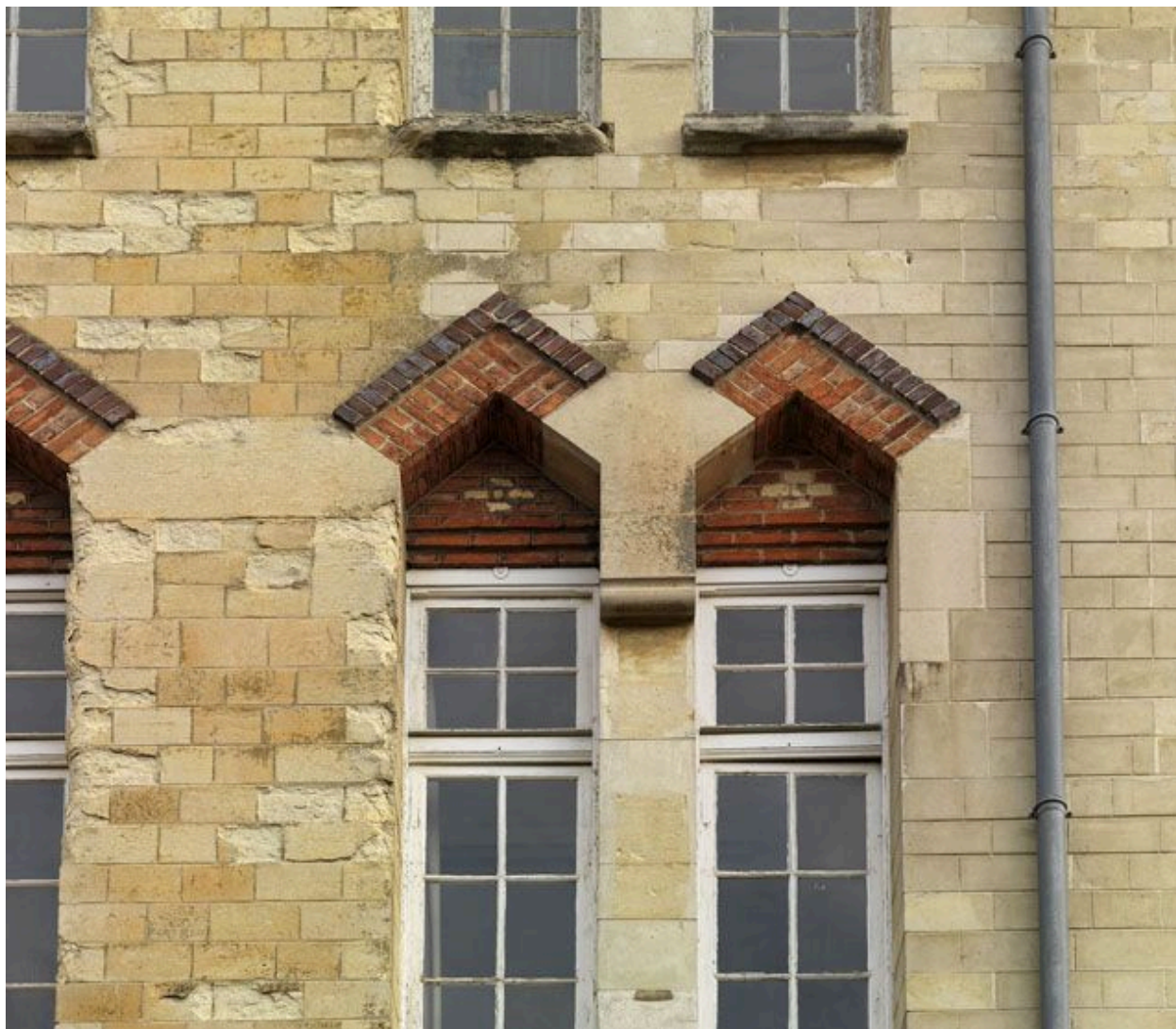
92, Sceaux, lycée Lakanal, 3-7 avenue du Président-Franklin-Roosevelt. Façade orientée vers l'ouest : détail des baies jumelées.
