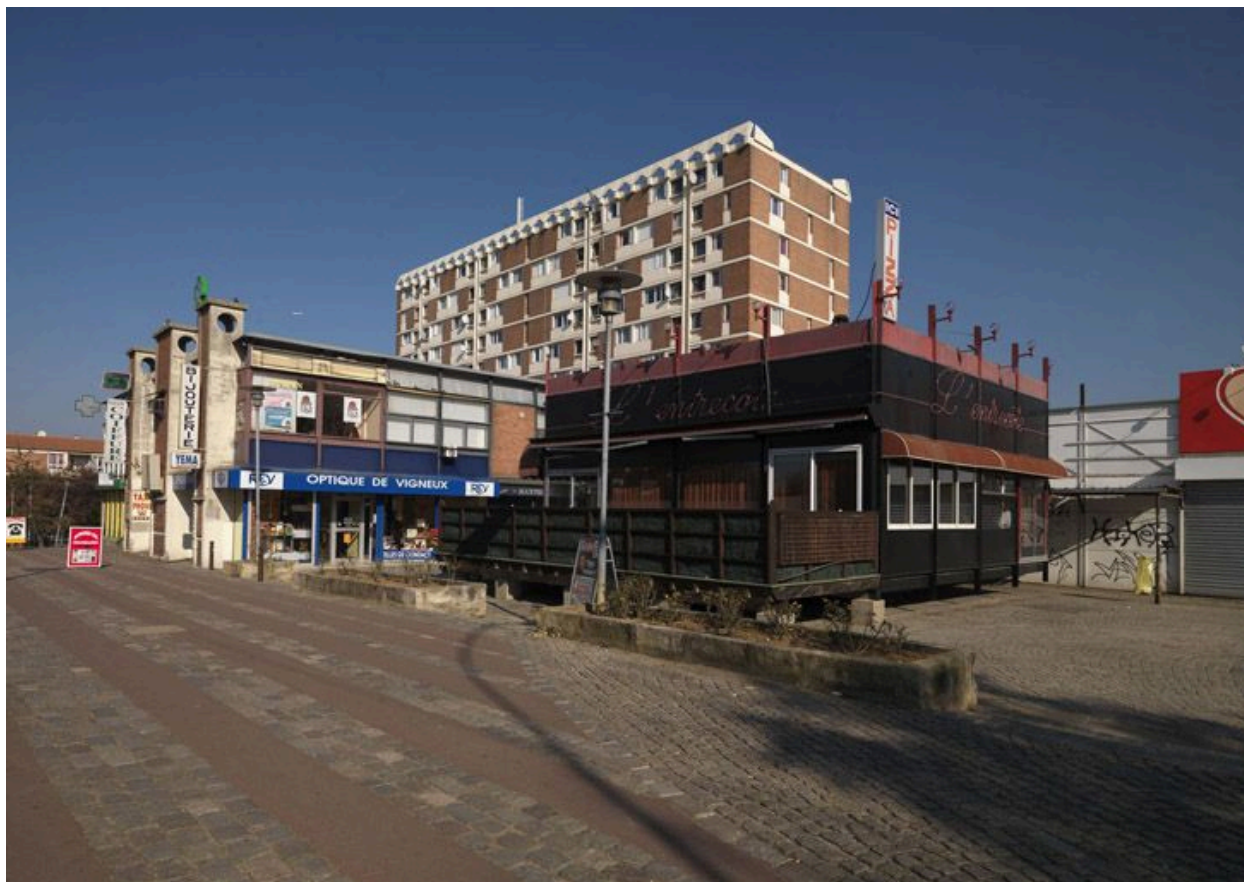
Le centre commercial de la Patte d'Oie avec, à l'arrière plan, l'immeuble R+9 des Briques Rouges.
