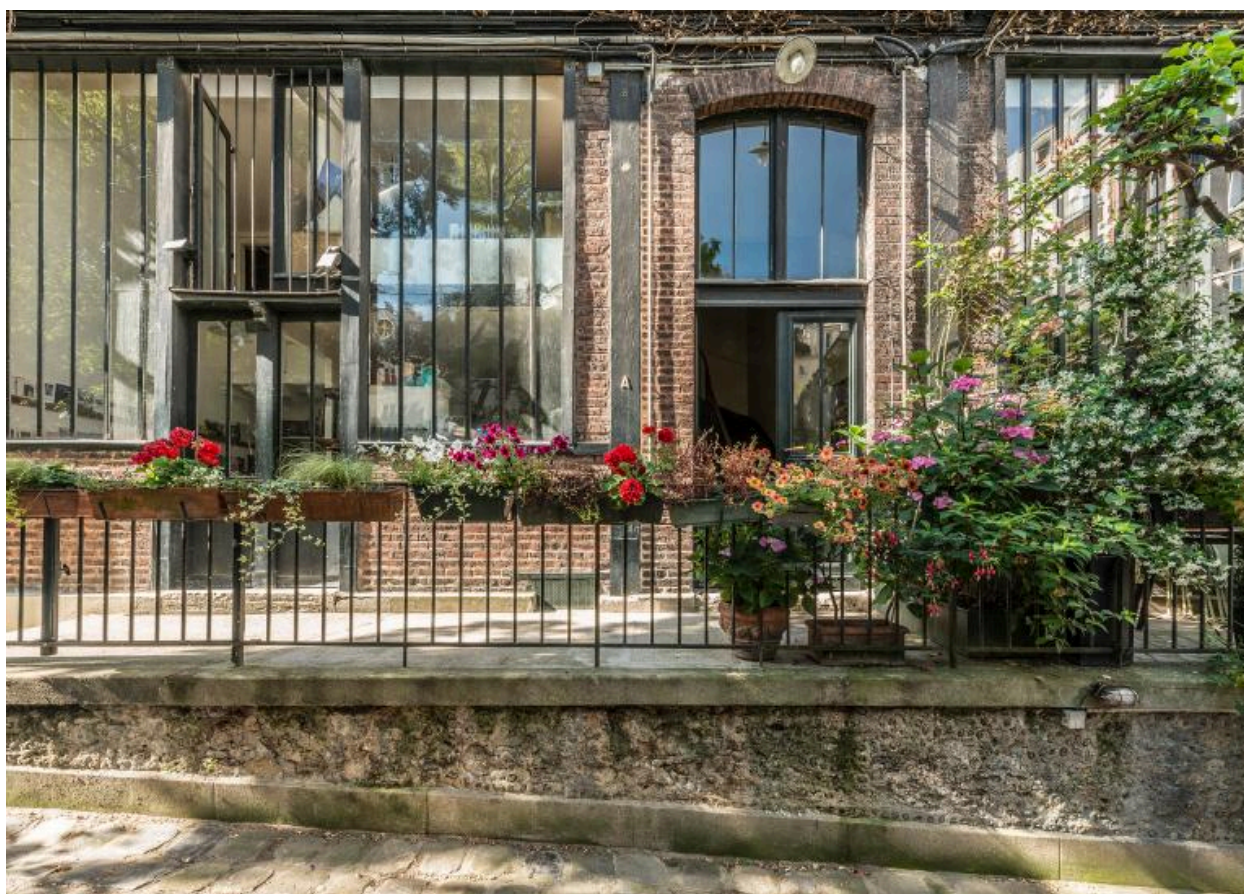
Vue des premiers ateliers de l'allée (1)
