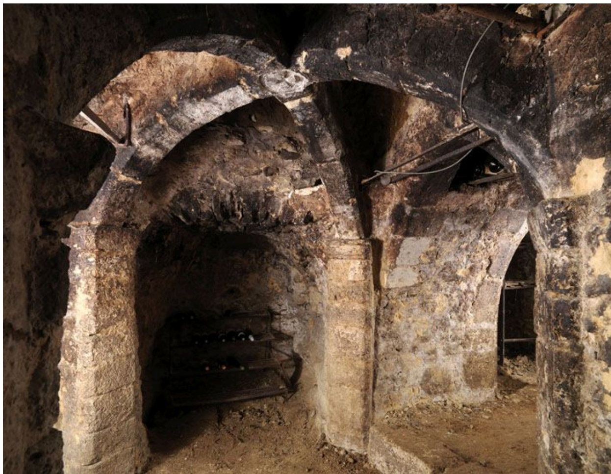
Cave. La salle nord et l'accès vers la salle nord-est.
