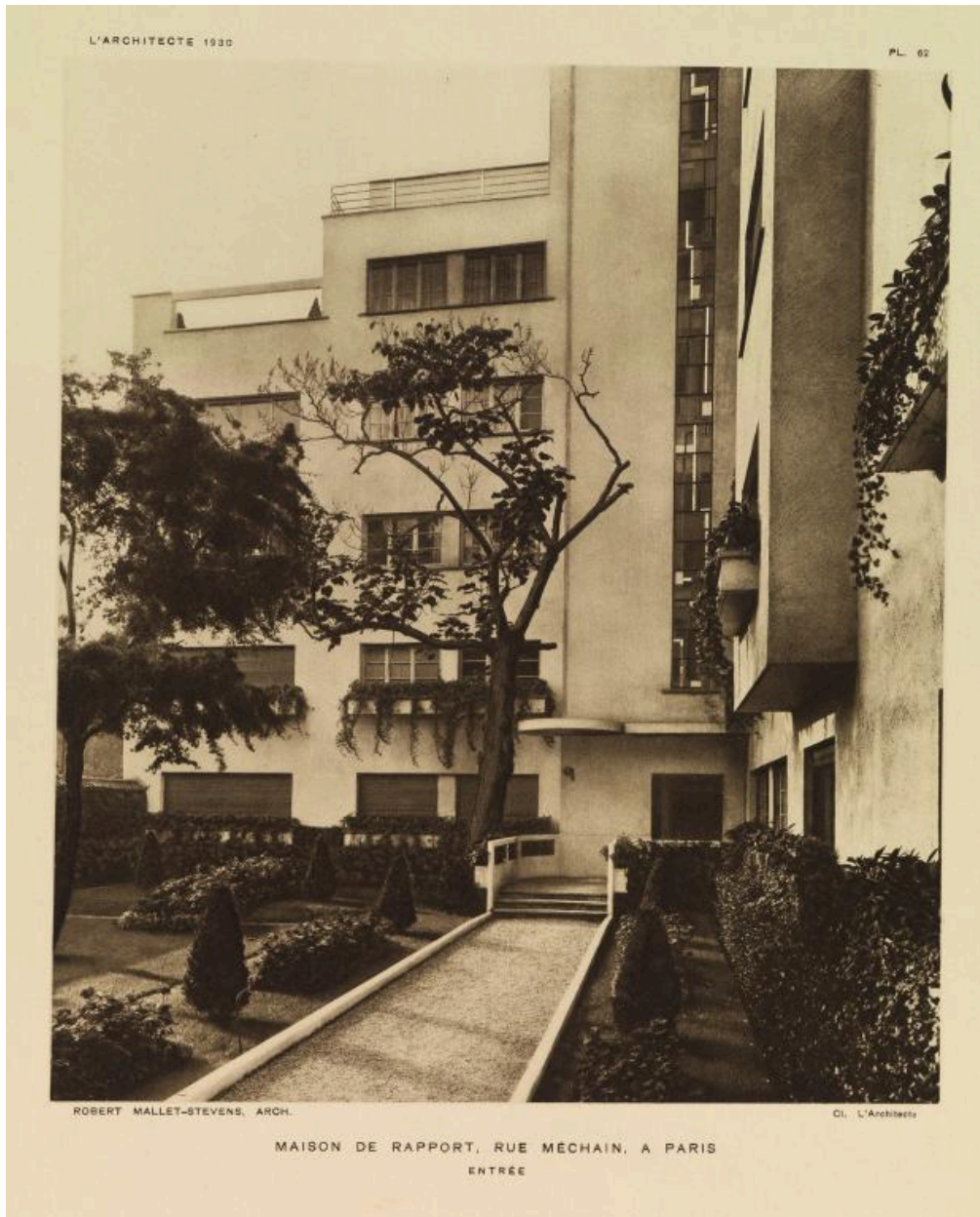
Entrée de la maison de rapport rue Méchain, reproduite dans la revue L'Architecte, 8e année, n°11, 1930, planche 62
