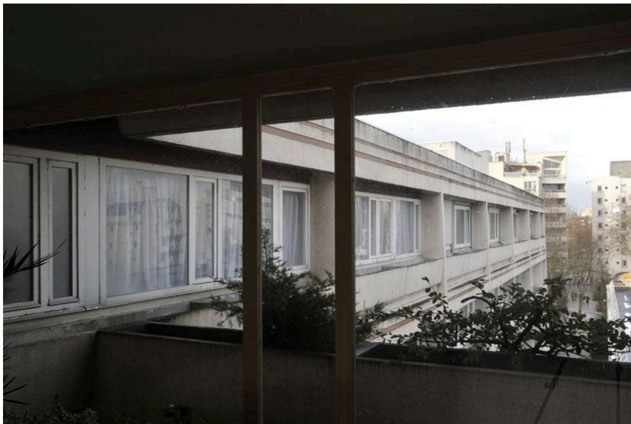
Patinoire : vue de la façade des logements.
