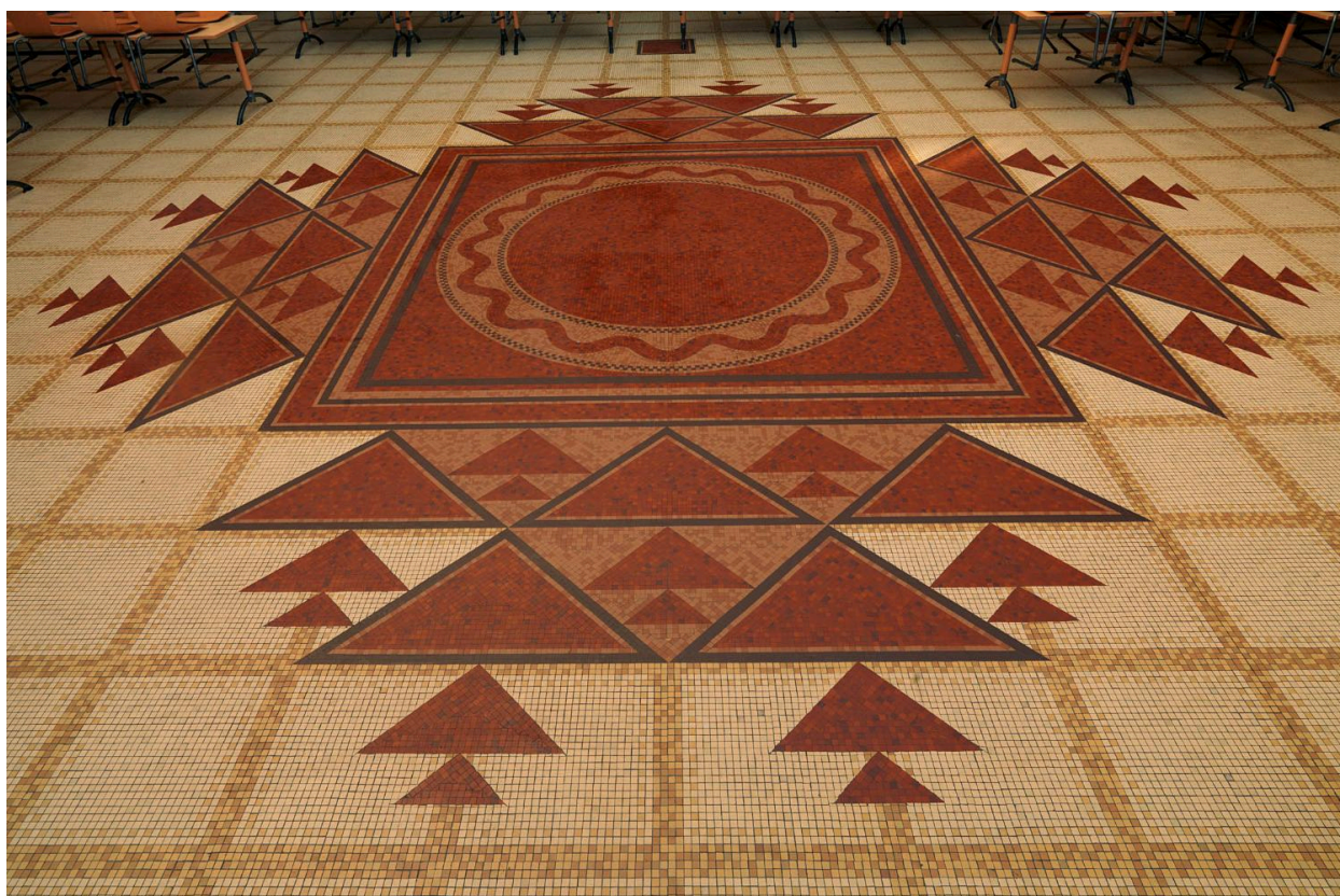
Détail du sol en mosaïque du réfectoire et de ses motifs géométriques.
