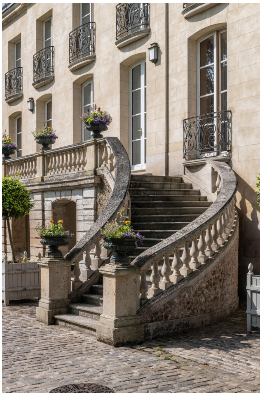
Détail de l'escalier extérieur. Le limon porte un revêtement rocaillé.
