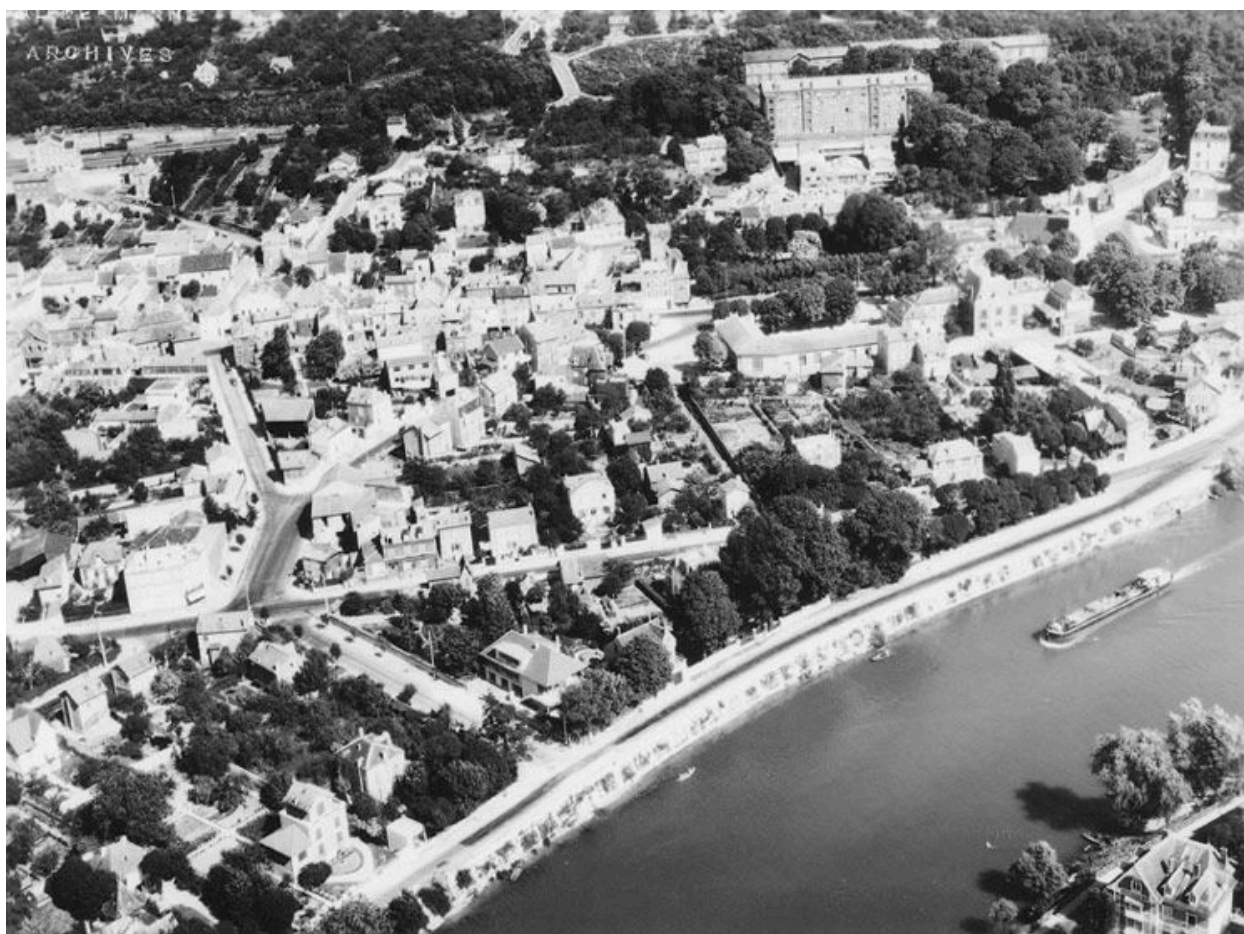
Vue aérienne de la boucle de la Marne, en arrière plan les bâtiments de l'hospice Favier. Photographie, 1959. (AD Val-de-Marne. 2Fi Bry 118)
