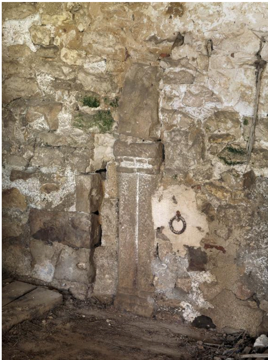
Détail de la salle 5 de la grange des Beauvais.
