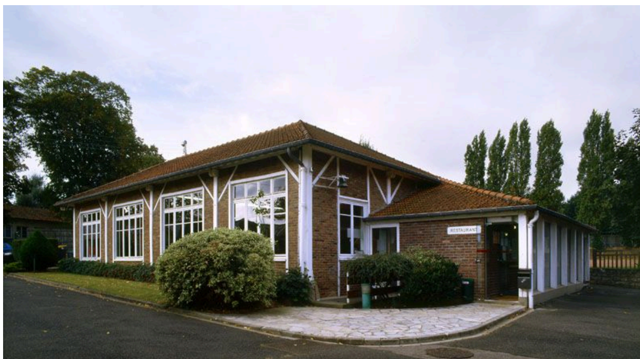
Ancienne salle de cours transformée en réfectoire.
