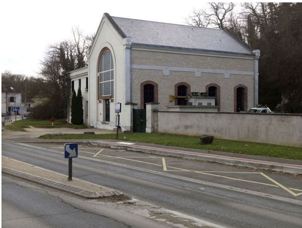
Bâtiment des pompes, depuis le nord-est.
