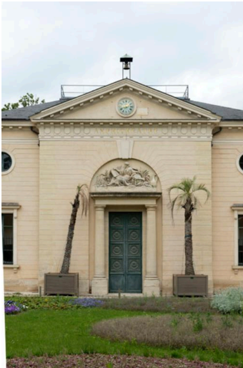
Elévation antérieure, avant-corps, vue générale.
