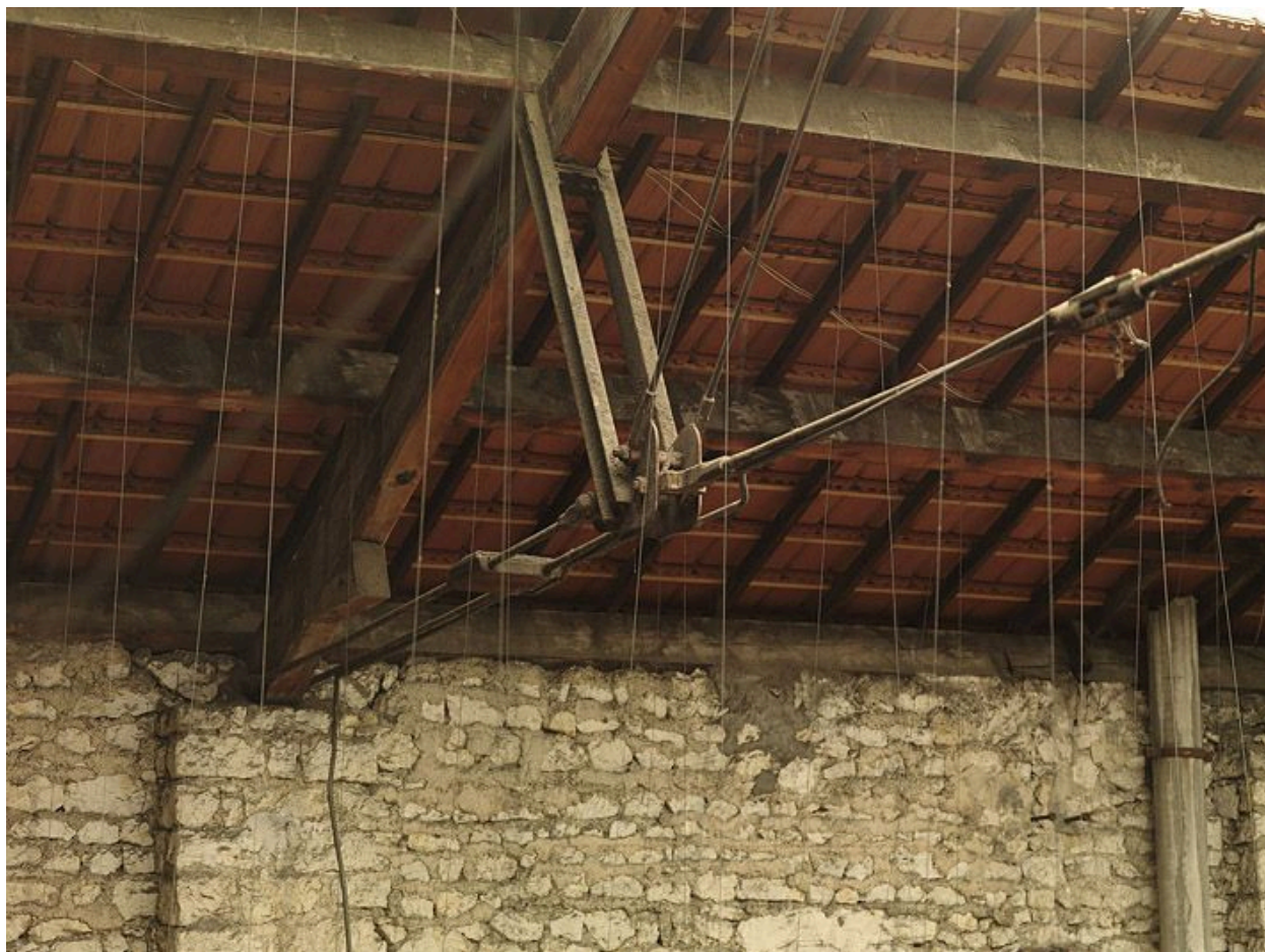
Détail de la charpente Polonceau de l'ancienne remise de voitures de la Compagnie des Tramways de Fontainebleau.
