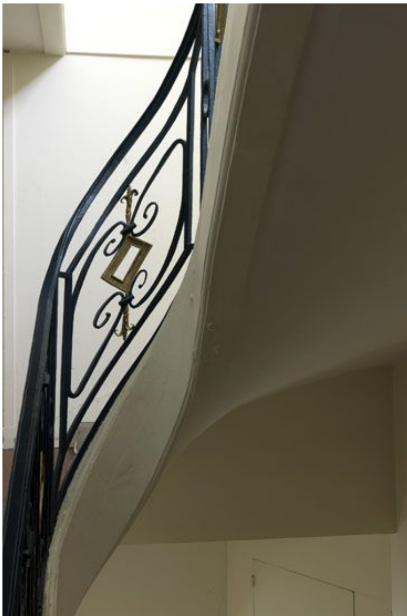
Détail d'un balustre dans la partie tournante avec le macle, armes des Rohan.
