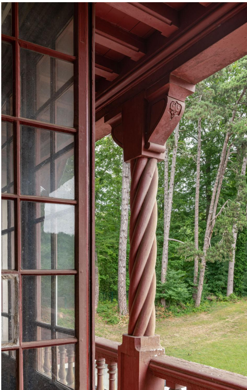
Détail de la galerie, façade est
