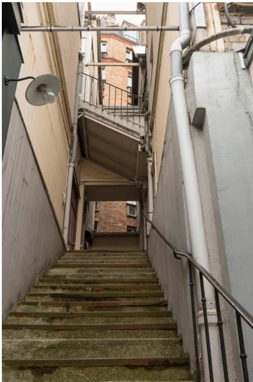
Accès aux ateliers construits dans l'entre-deux-guerres
