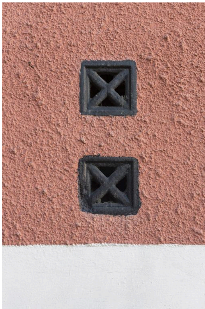
Détail du système d'aération ouvert sur la façade
