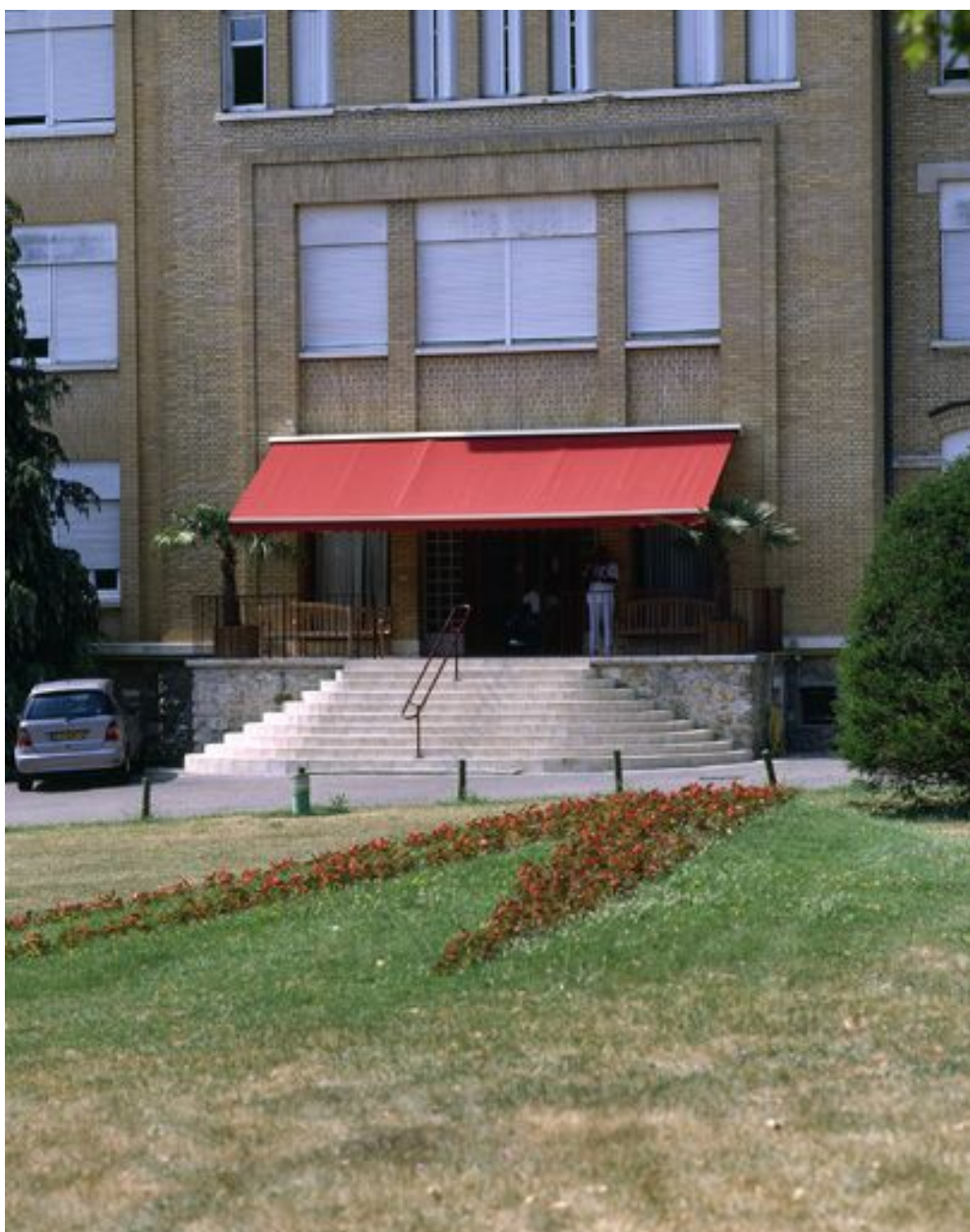
Vue de l'entrée sur la partie centrale du bâtiment.
