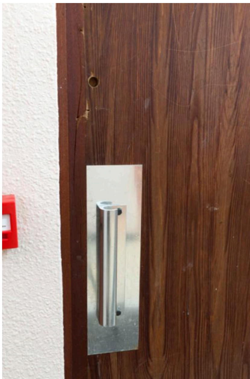
Lycée Rostand : détail d'une poignée de porte d'origine.
